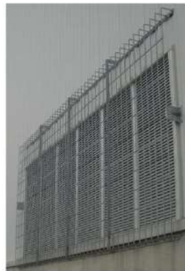
循環水ポンプ建屋外気取入口 (屋外側)
