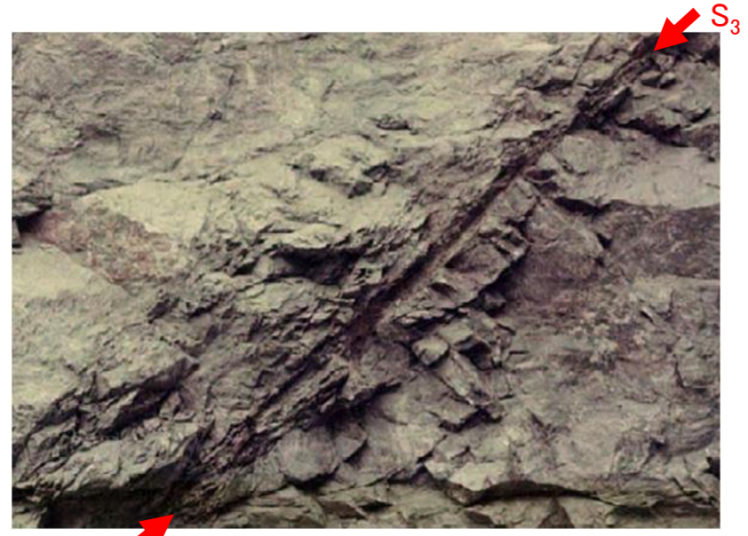
※基礎トレンチ内で昭和51年撮影
