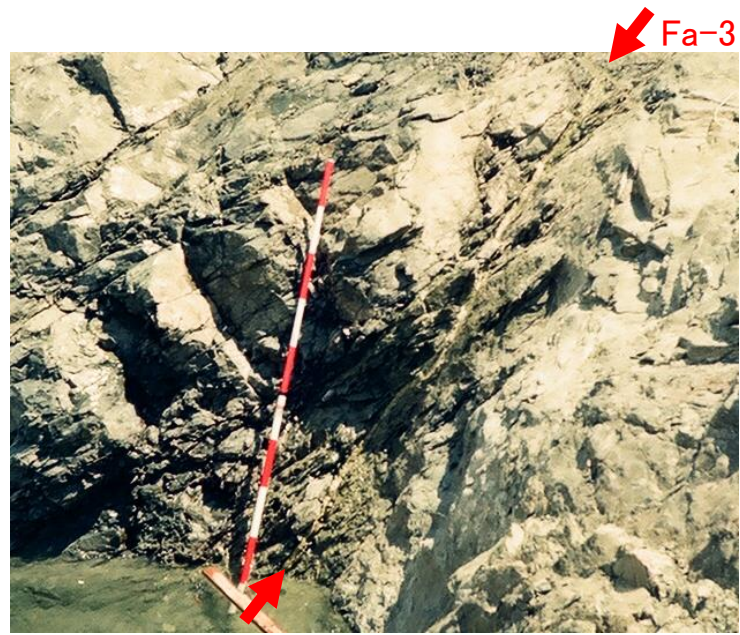
※基礎掘削面で平成2年撮影
