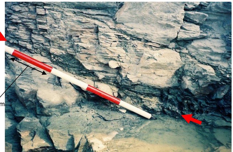
※基礎掘削面で平成2年撮影
