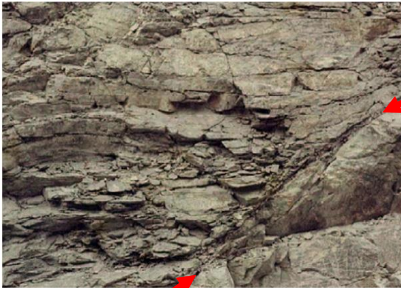
※基礎トレンチ内で昭和51年撮影
