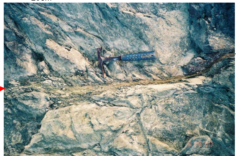
※基礎掘削面で平成2年撮影
