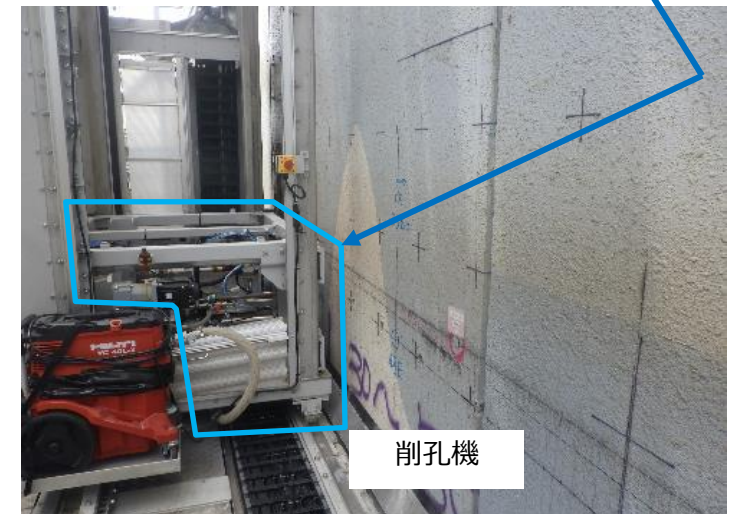
<現場削孔状況>
