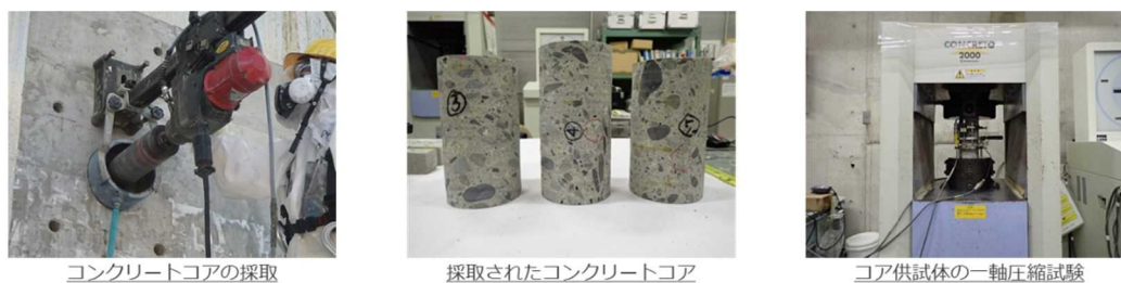
図 25 コンクリート強度調査状況
