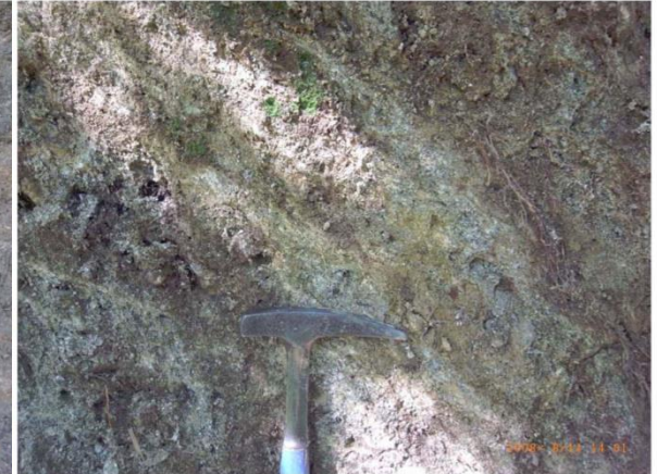
写真2 片状カタクレーサイトの状況
