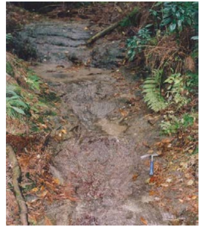
写真1 リニアメント延長位置の健岩の露頭状況
