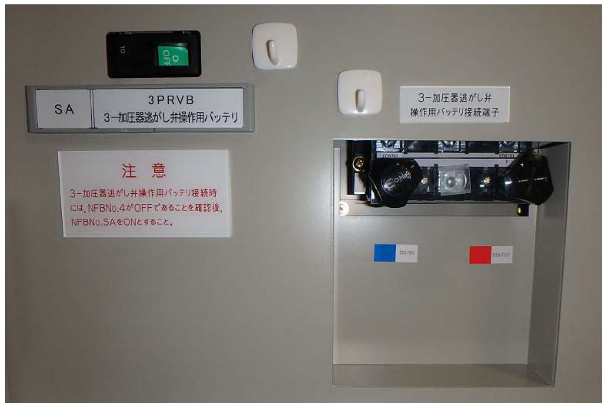
加圧器逃がし弁操作作用バッテリー取付箇所 (3-ソレノイド分電盤B1) (3SDB1)
