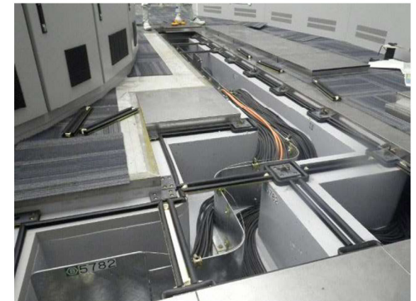
○フロアケーブルダクト内に敷設された光ファイバ温度センサー
