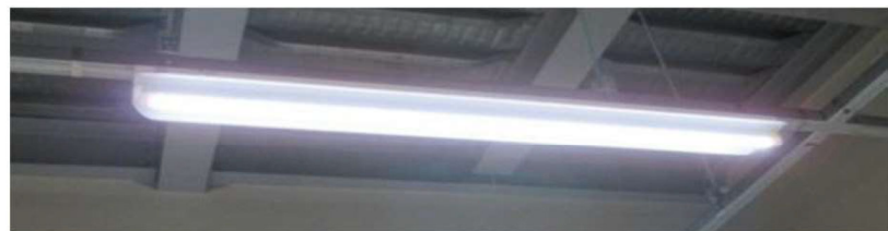
無停電運転保安灯 <仕様>・定格電圧：交流100V,200V ・点灯可能時間：4時間以上
