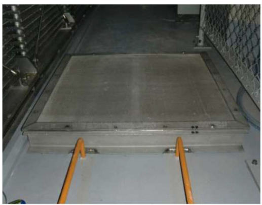
格納容器再循環サンプ入口
