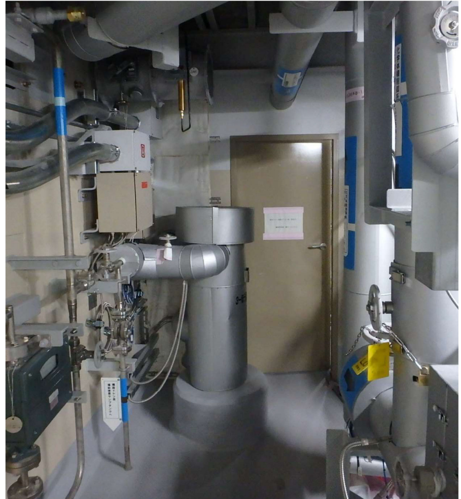
1 時間耐火隔壁等設置後
