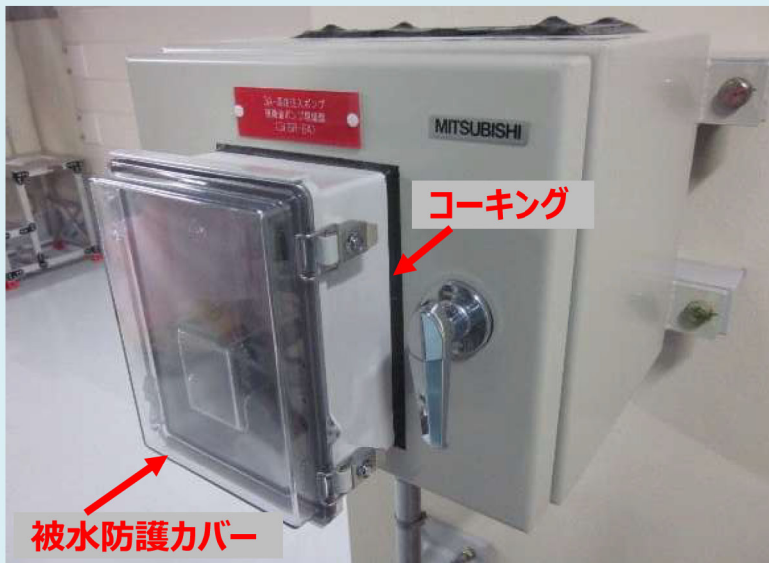
被水防護カバー取付状況
