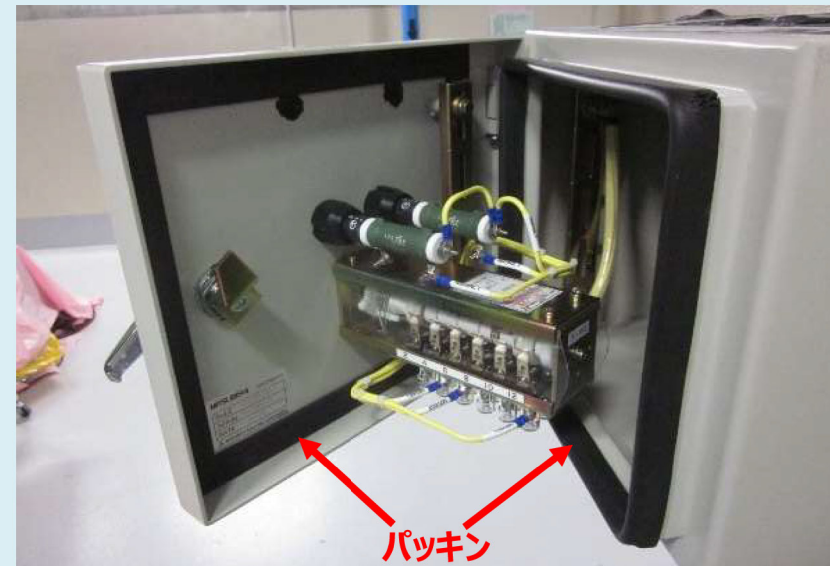
扉パッキン取付状況
