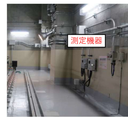
⑦使用済燃料ピット周り
