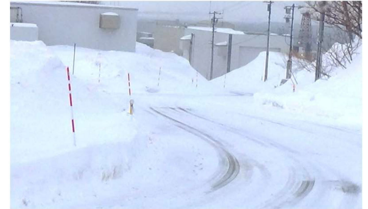
スノーポールの設置
