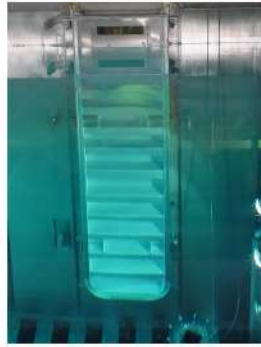
ゲートの設置状況
