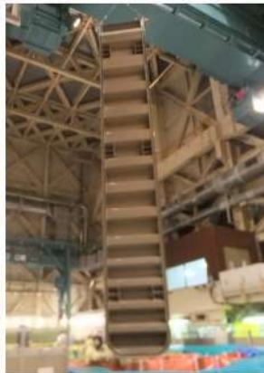
ゲート吊上げ作業 (写真は2号機)
