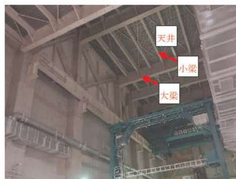
図 5.2.2 燃料取扱棟の屋根
