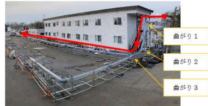
添付5-4(1)図 モックアップ試験装置の全景（ルート1）
