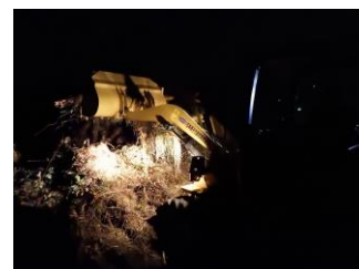
がれき撤去（夜間）
