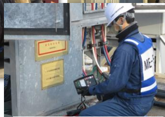
端子接続、絶縁抵抗測定
