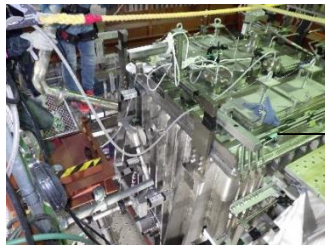
3号溶融炉の組立状況(付帯配管等取付)
