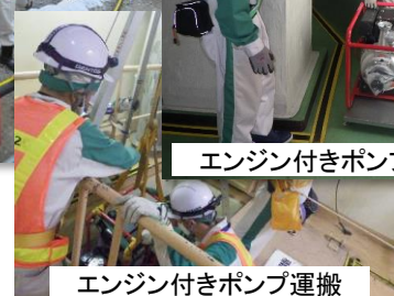
エンジン付きポンプを用いた外部からの給水操作
