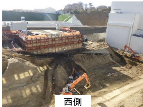
事故対処設備配備場所の地盤補強工事の状況（2022年12月）
