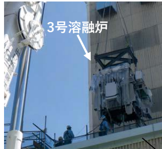
3号溶融炉のクールド施設への搬入作業
