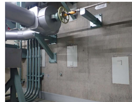
原子炉補助建屋 外壁（2号炉）
