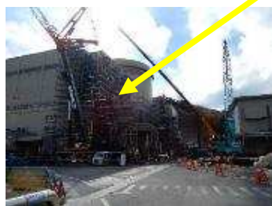
西側減築工事中
