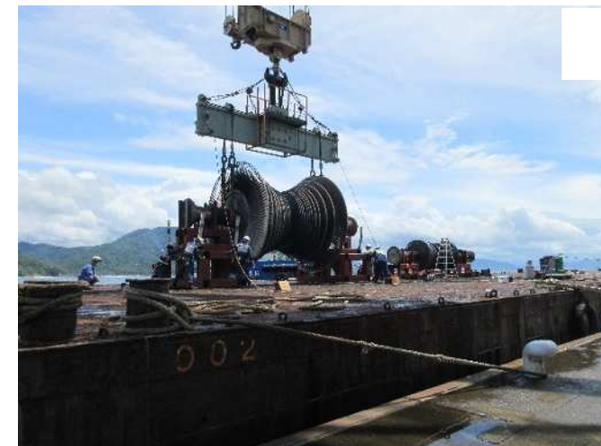
⑤岸壁クレーンにて運搬台船に積込み (右奥は1号機の高圧タービン)
