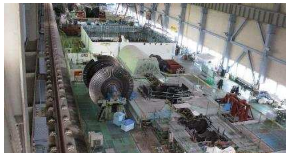
2号機低圧タービン吊り上げ
