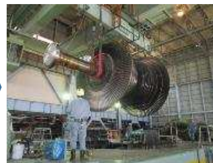
2号機低圧タービン吊り上げ
