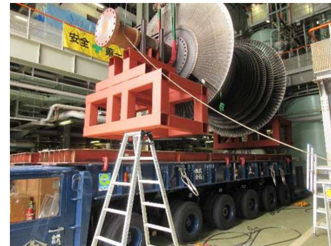
②大型輸送車へ吊り込み
