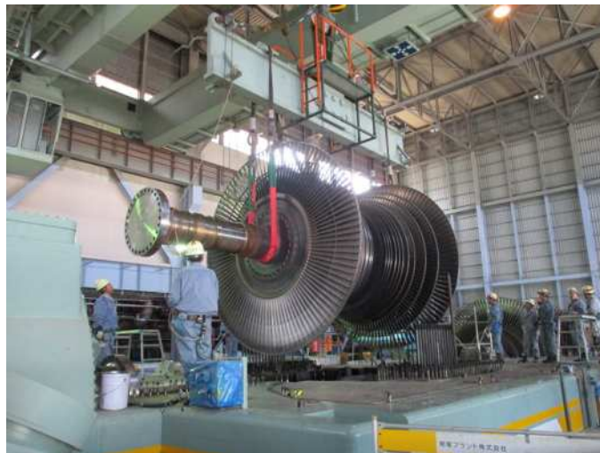
①ローター吊り上げ(2019年)
