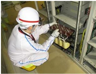
③電気盤等の解体撤去
