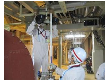
④ユーティリティ配管撤去
