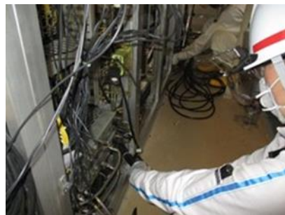
②電気・計装撤去
