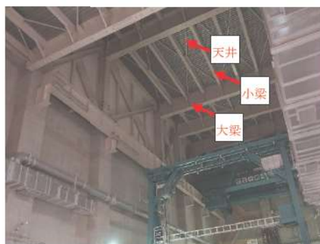
図 5.2.2 燃料取扱棟の屋根
