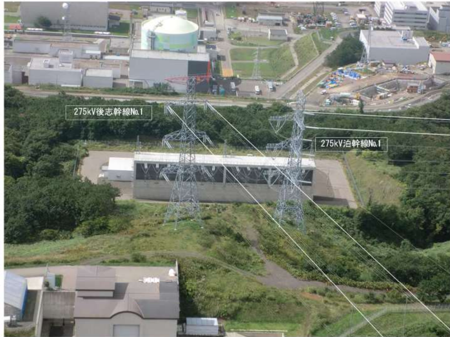
第 2.2.3.3 図 ①近接箇所の現地状況 (1/3)
