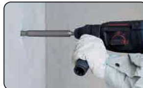
③ 打込み (専用マシホルダー使用)
