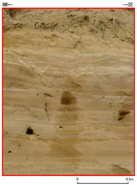
露頭拡大(F-5断層南東側)
