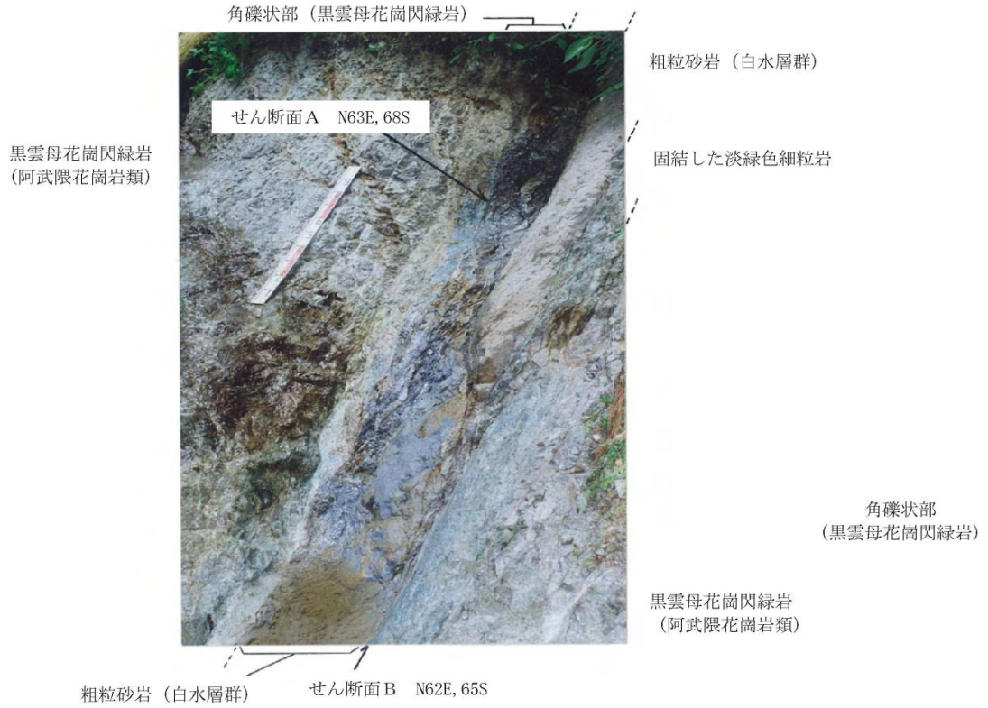
写真1 露頭傾斜部全景
