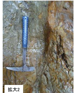
砂岩と泥岩の境界の断層面の連続性はやや不明瞭でしばしば分岐し、平面性は低い。また幅約5mmの砂礫岩を挟んでいるが、粘土状破碎部を伴わない。砂礫岩は、周囲の砂岩層と同様の固結の程度である。
