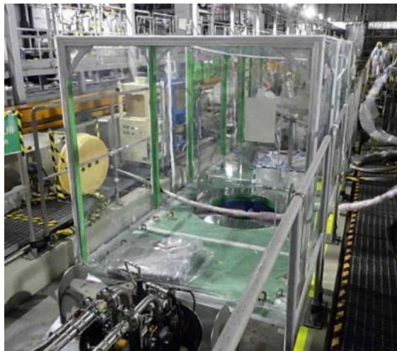
作業ハウス 外観
