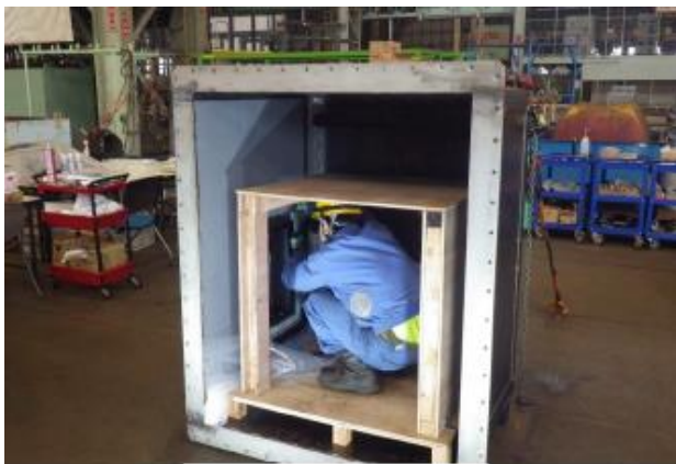
金属板取付け
