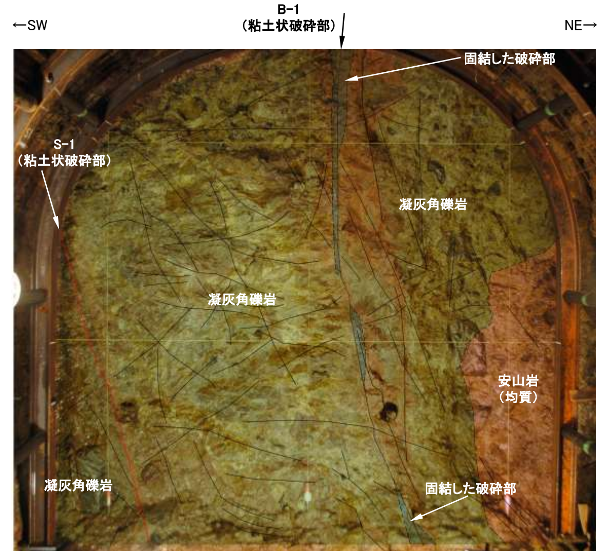
No.15切羽写真(割れ目等を加筆)
