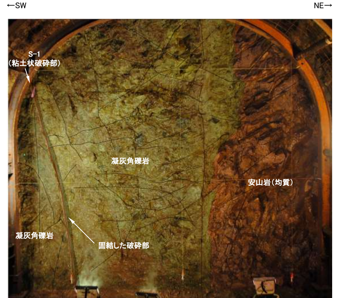
No.27切羽写真(割れ目等を加筆)
