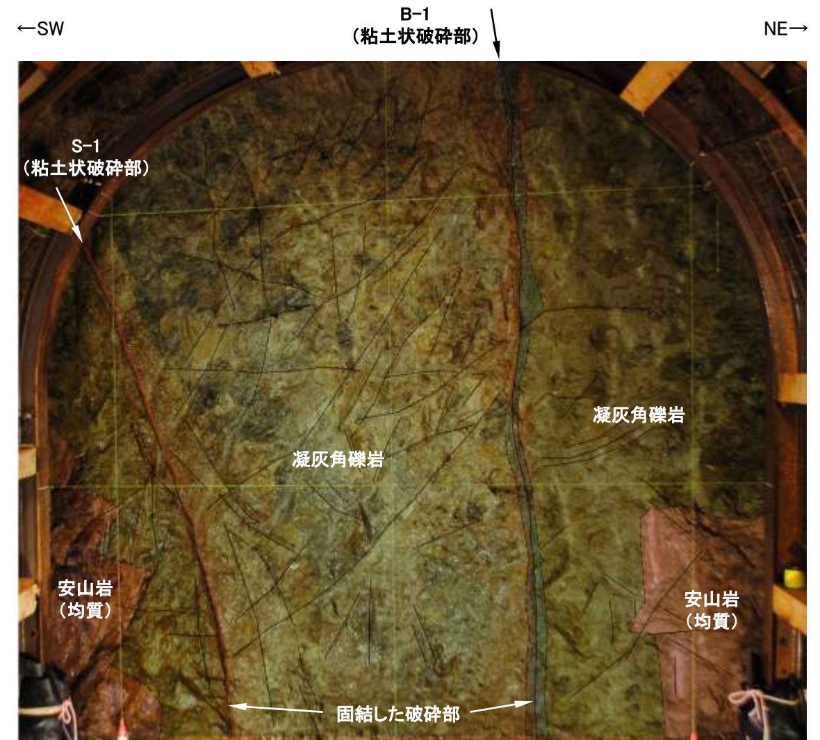
No.11切羽写真(割れ目等を加筆)
