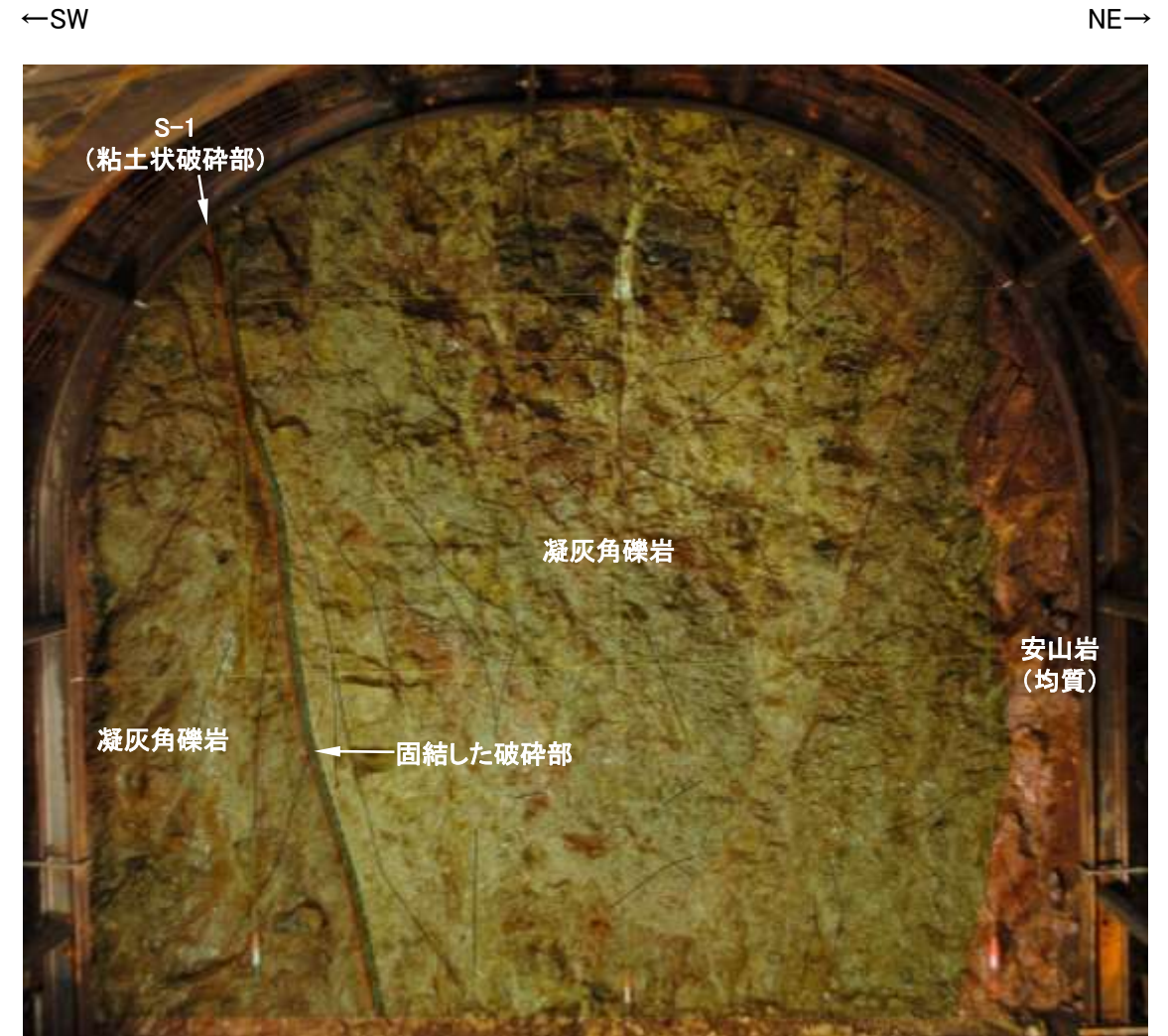
No.30切羽写真(割れ目等を加筆)
