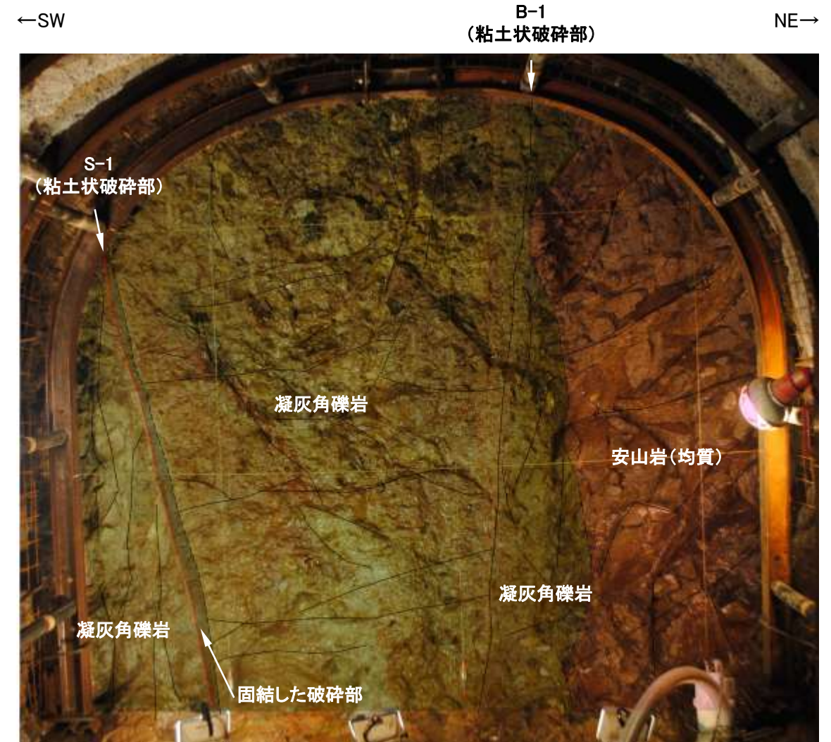
No.26切羽写真(割れ目等を加筆)
