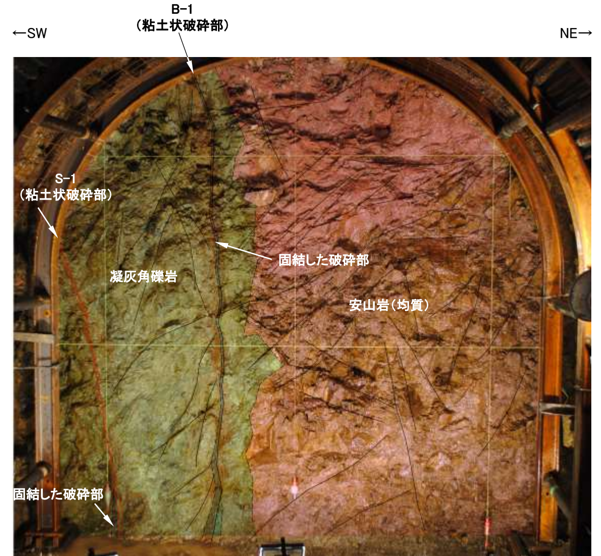
No.5切羽写真(割れ目等を加筆)
