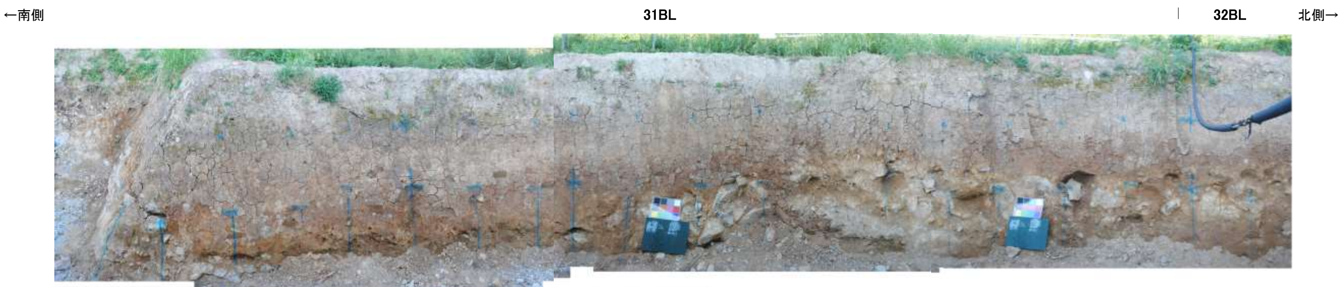
防潮堤設置時写真[31BL, 32BL]①
