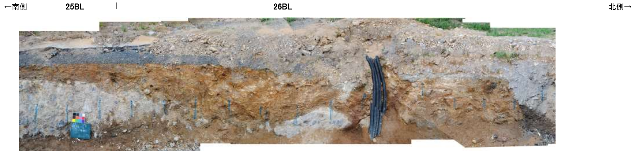
防潮堤設置時写真[25BL, 26BL]②
