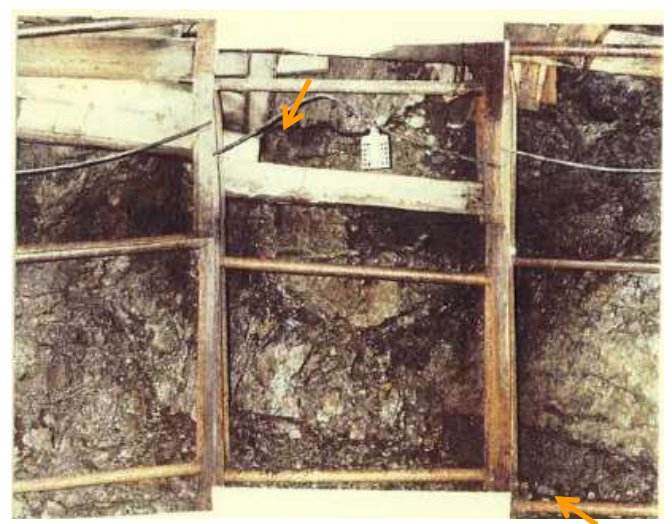
試掘坑調査結果 (1号炉試掘坑C 68~70m付近)(北側側壁)
