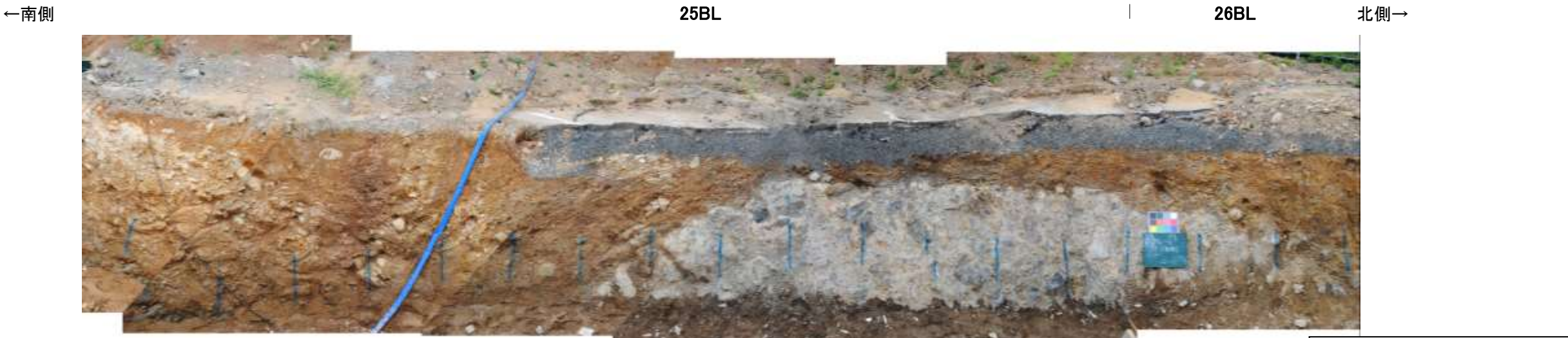
防潮堤設置時写真[25BL, 26BL]①
