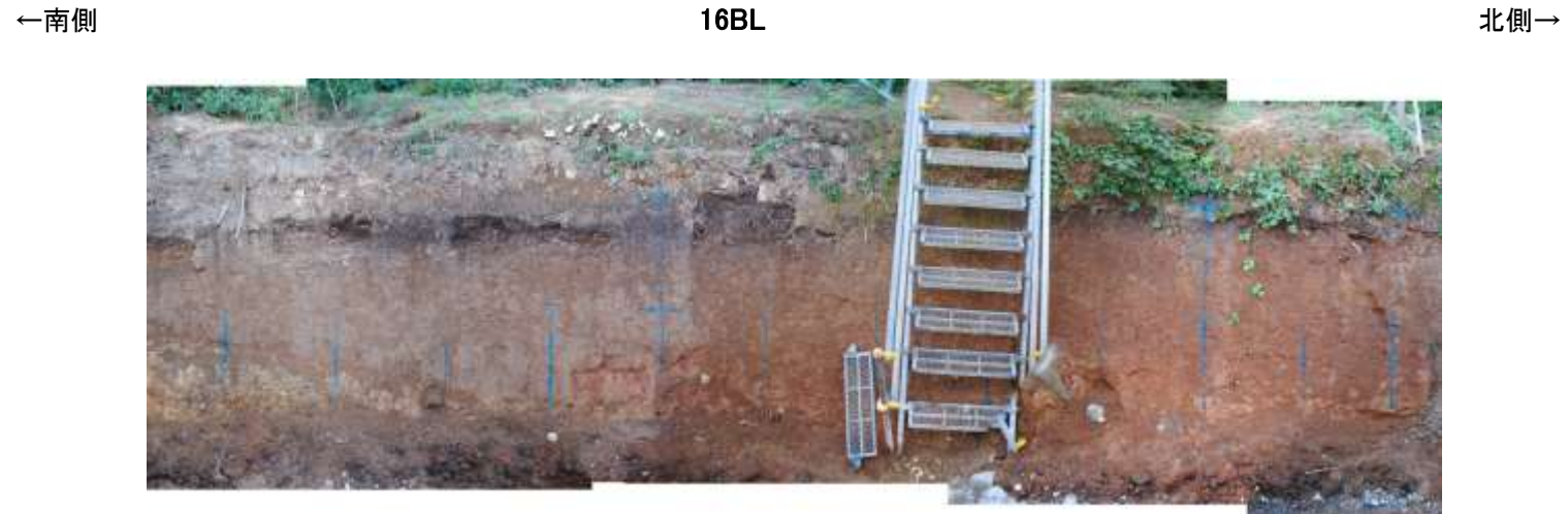
防潮堤設置時写真[16BL]
