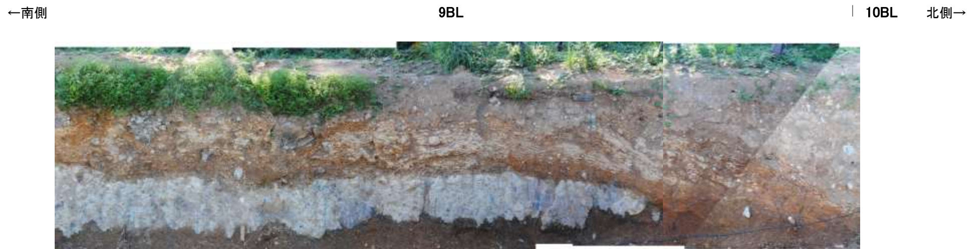
防潮堤設置時写真[9BL, 10BL]①
