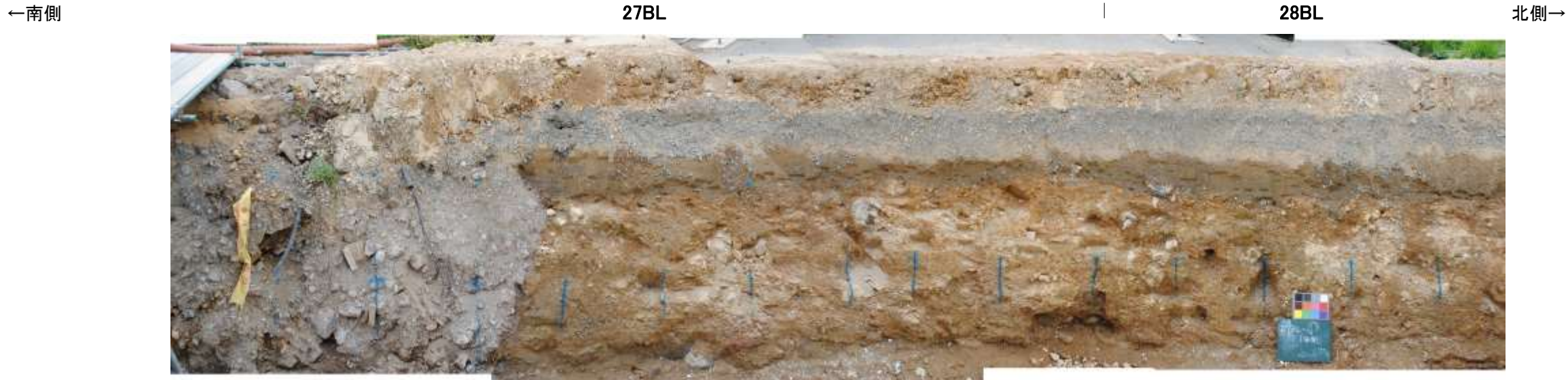
防潮堤設置時写真[27BL, 28BL]①
