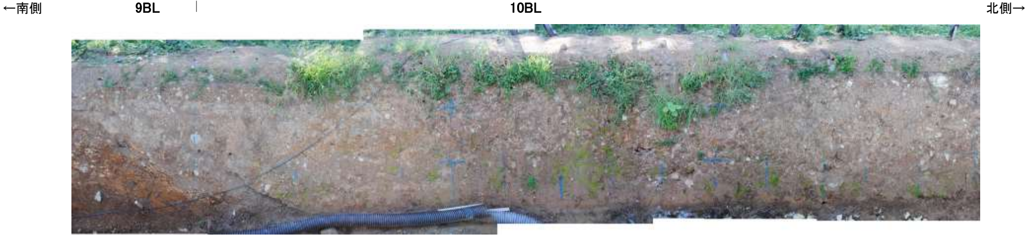
防潮堤設置時写真[9BL, 10BL]②
