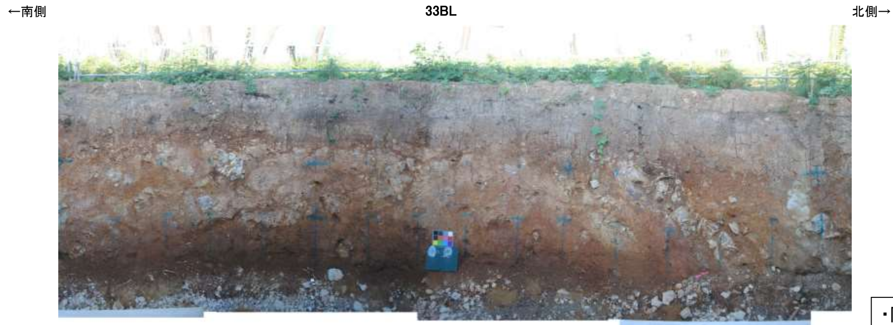
防潮堤設置時写真[33BL]
