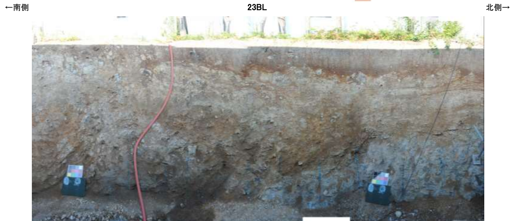
防潮堤設置時写真[23BL]
