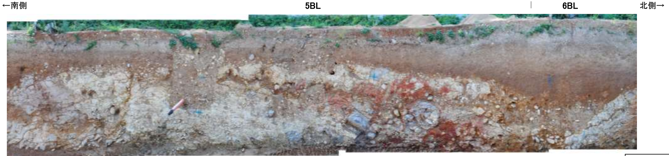
防潮堤設置時写真[5BL, 6BL]①
