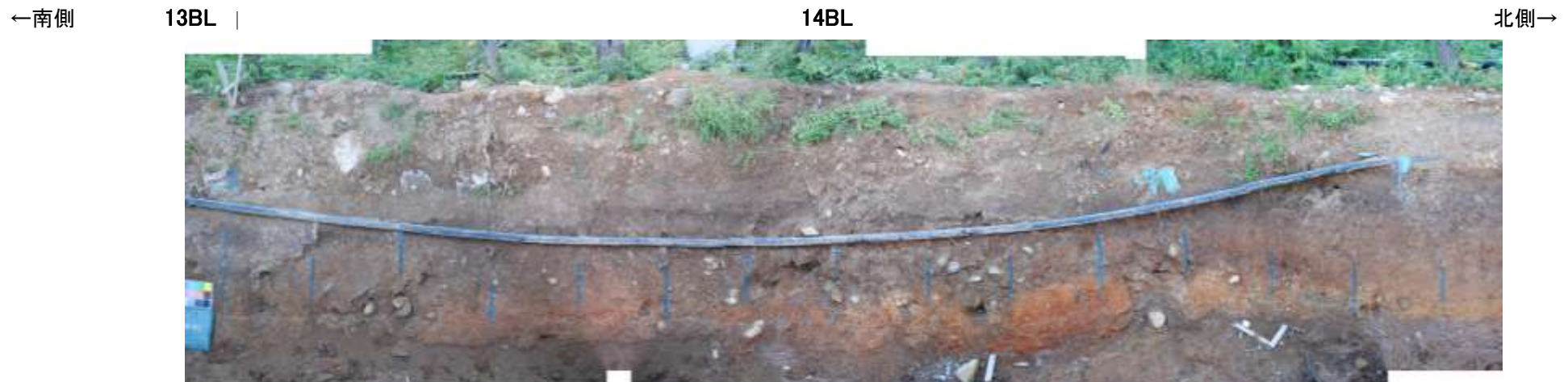
防潮堤設置時写真[13BL, 14BL]②
