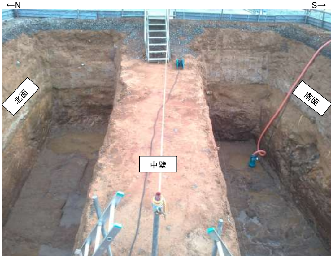
北側 南側 中壁 トレンチ状況写真(西側から撮影)
