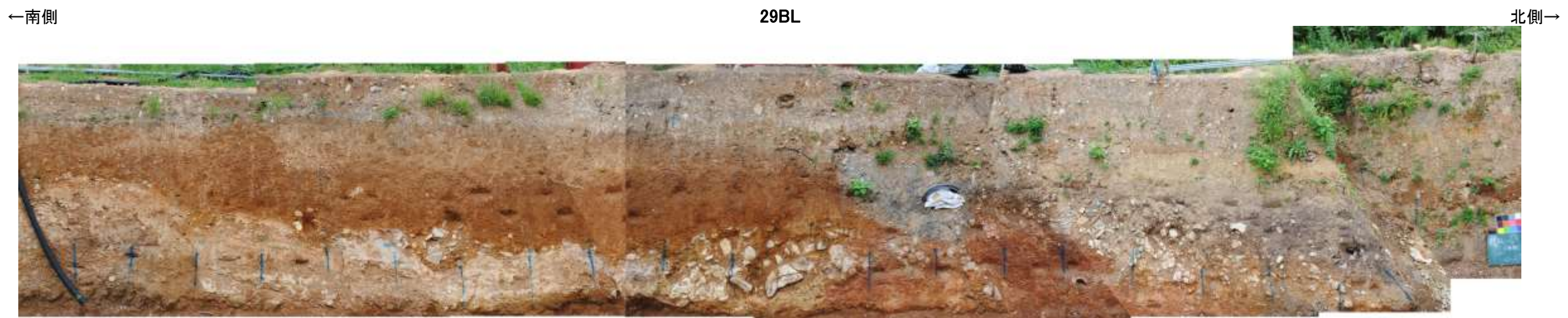
防潮堤設置時写真[29BL]
