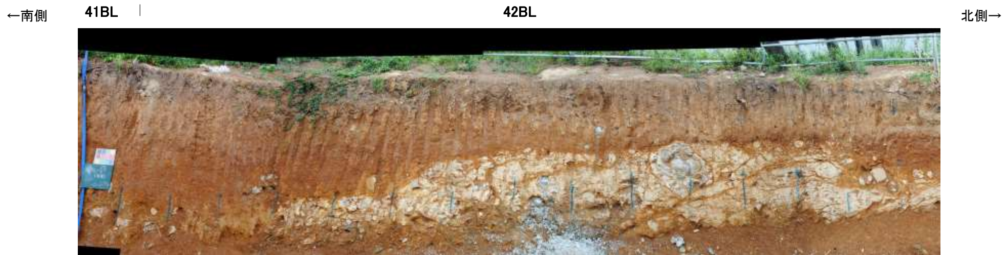
防潮堤設置時写真[41BL, 42BL]②
