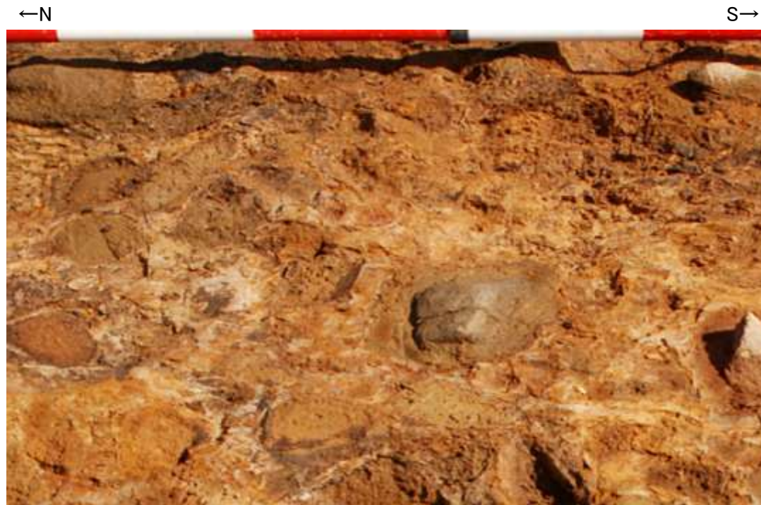
35m盤法面 堆積物の拡大写真
