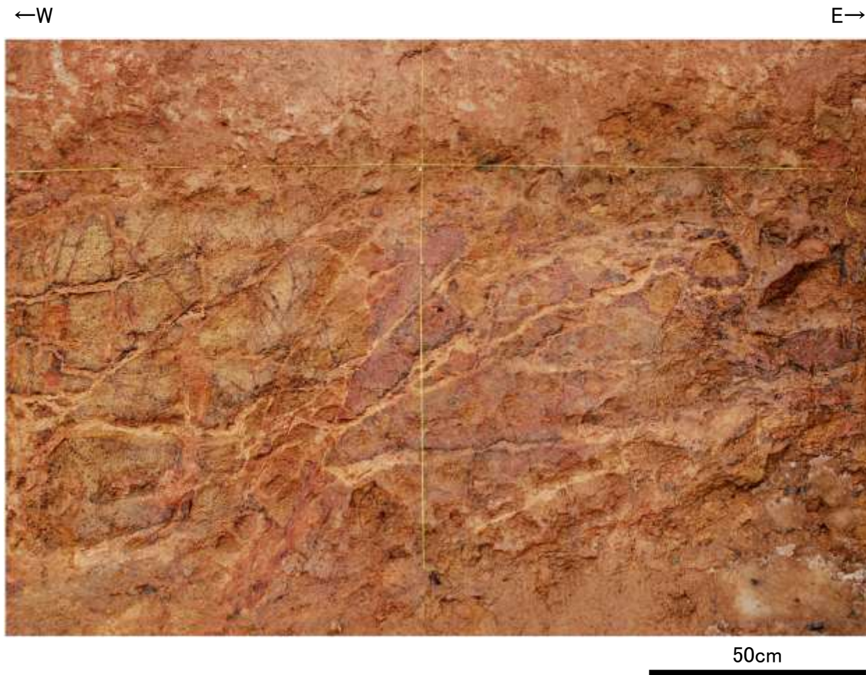
新北面写真(2022年1月撮影)
