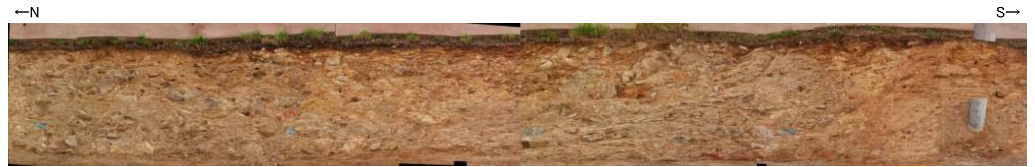
写真 (35m盤法面)
