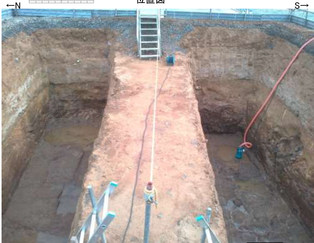
トレンチ状況写真(西側から撮影)
