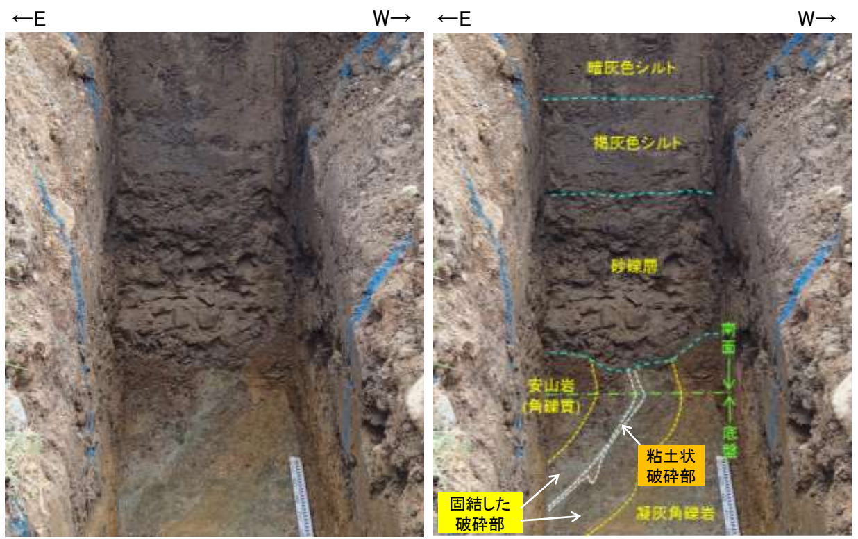
南面 拡大写真
