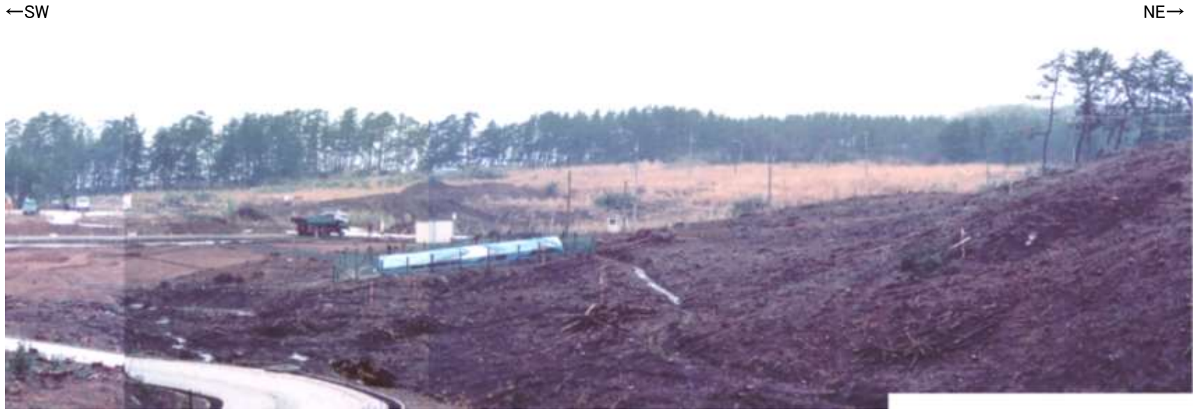
建設時写真(樹木伐採後)
