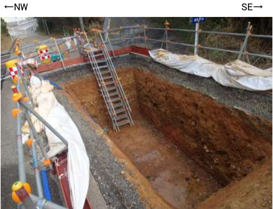
トレンチ状況写真(南西側から撮影)
