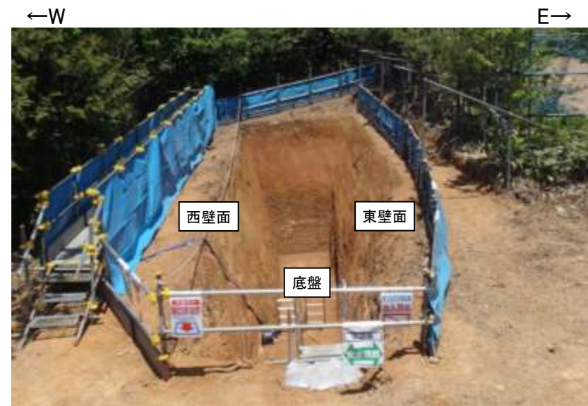
トレンチ状況写真(南側から撮影)
