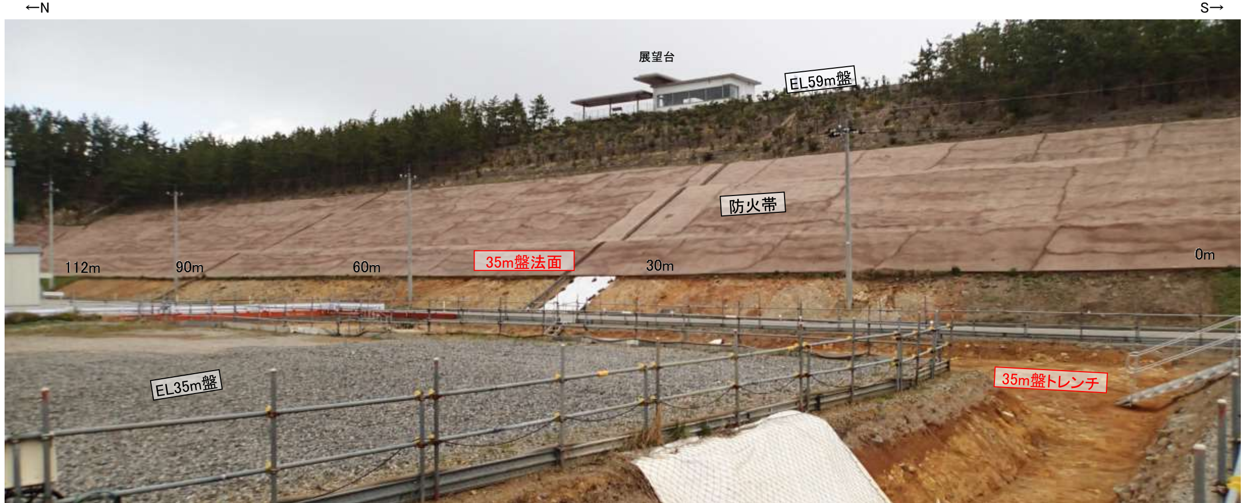
35m盤トレンチ及び35m盤法面 全景写真
