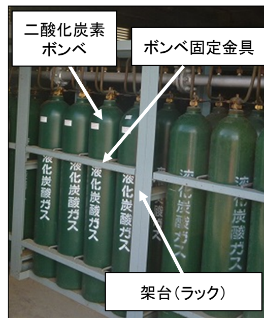
図18 敷地内におけるボンベの設置状況
