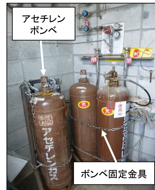
図18 敷地内におけるボンベの設置状況
