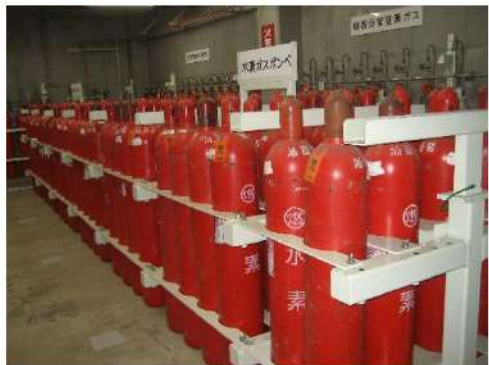
2号炉発電機ガスボンベ庫
