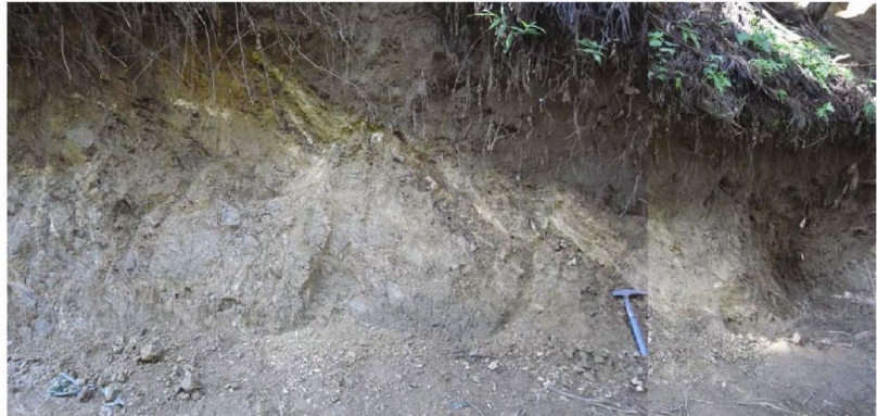
断層部の全景
