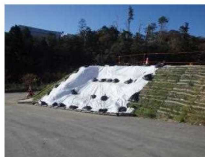
【応急処置後の状況】
