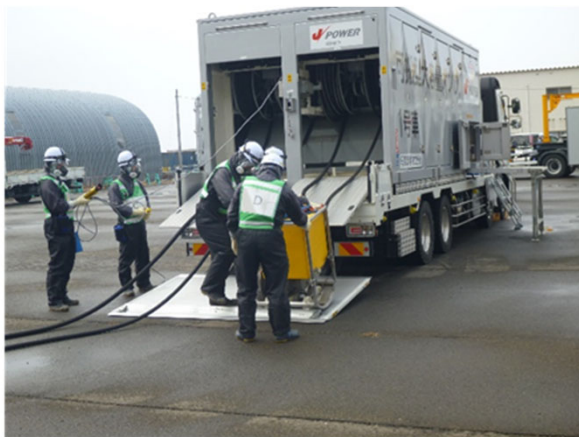
水中ポンプ設置 (可搬型大容量ポンプ)
