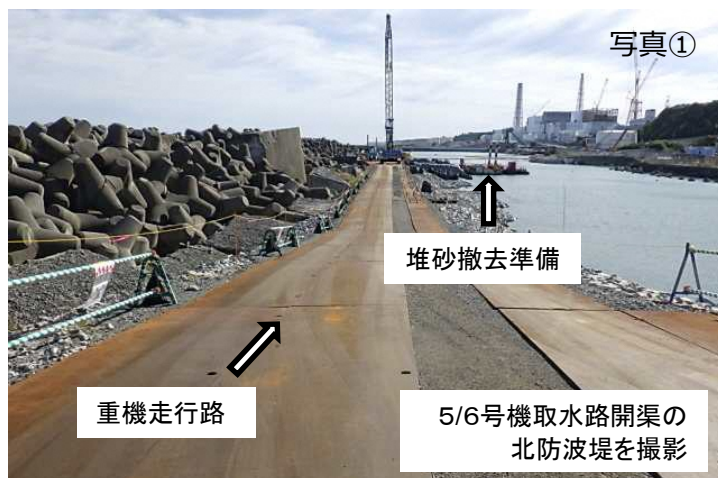
重機走行路整備・堆砂撤去準備の状況
