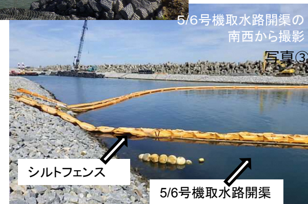
5・6号機海側工事エリアの状況
