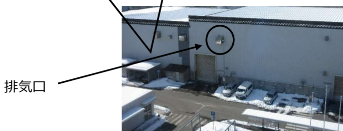
3号機給排水処理建屋
