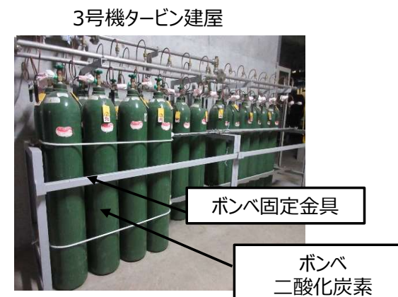
図 発電所におけるボンベの設置状況
