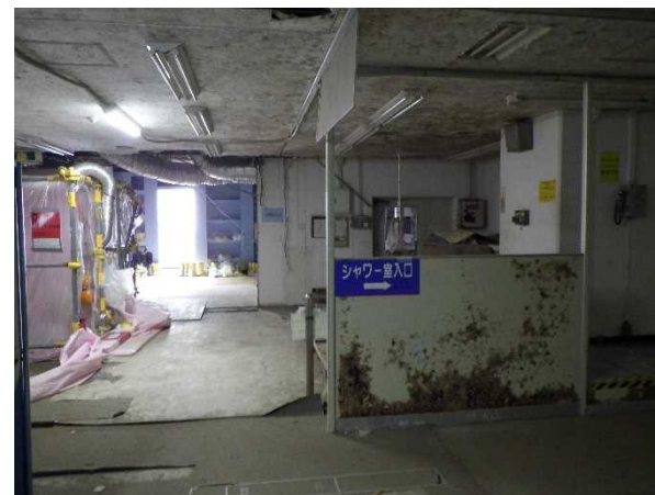
建屋北西付近
