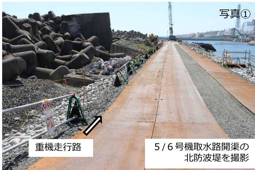
重機走行路整備の状況
