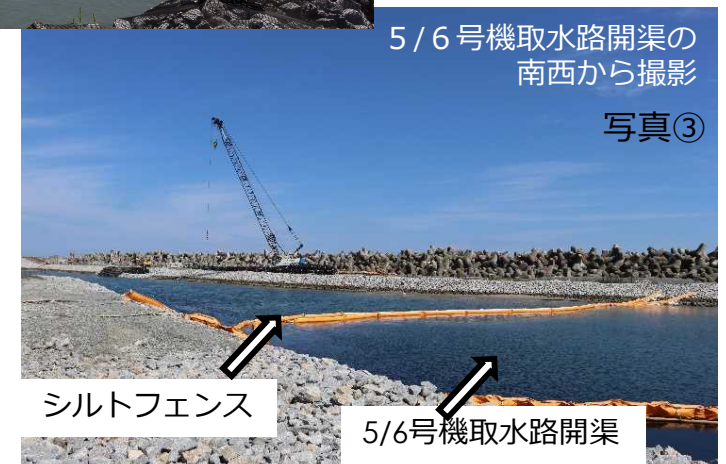
5・6号機海側工事エリアの状況
