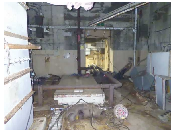
中央ハッチ付近
