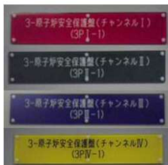
盤の識別 (原子炉安全保護盤の例)
