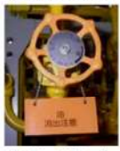
油類に係る弁 弁の識別
