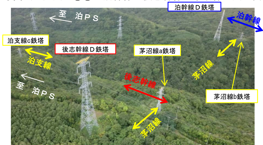
写真 (2) 交差②③：泊幹線・後志幹線と茅沼線の交差箇所
