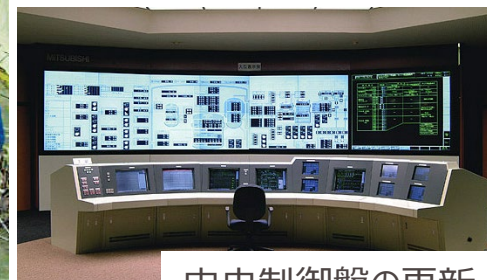
中央制御盤の更新
