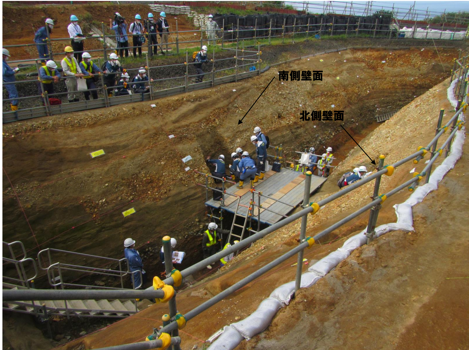
開削調査箇所(北側)
