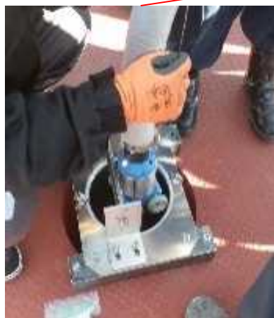
配管内アクセス装置挿入(3階)
