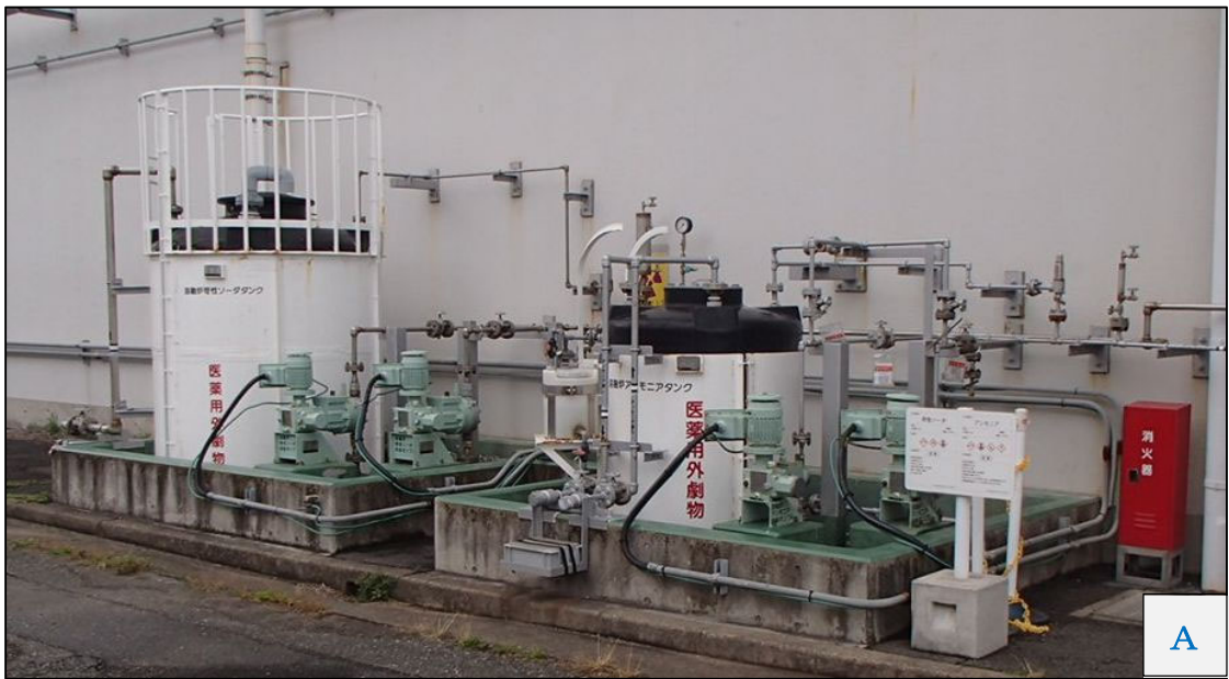
第2図 堰周りの状況（溶融炉アンモニアタンク）
