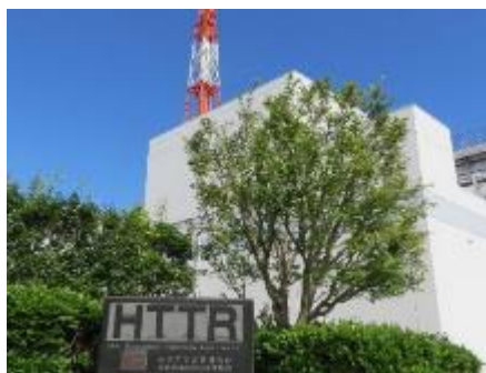
HTTR(高温工学試験研究炉)
