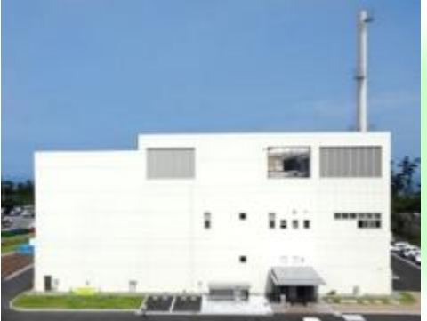
OWTF(平成31年3月施設完成)
