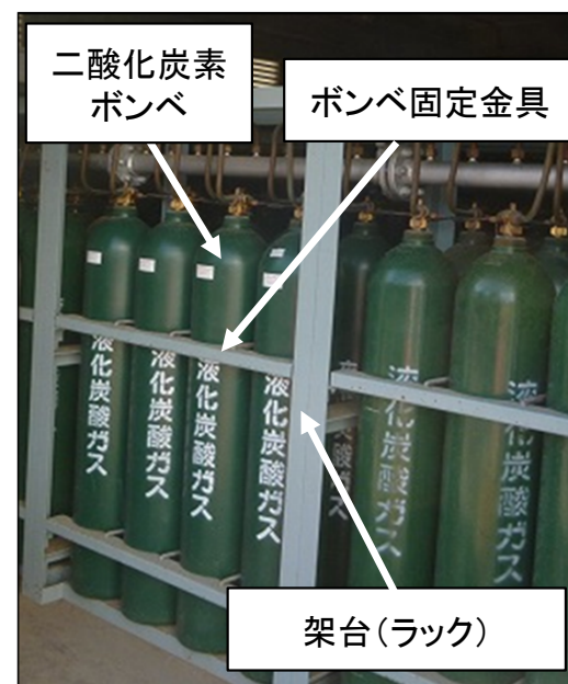
図18 敷地内におけるボンベの設置状況
