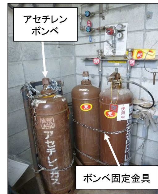
図18 敷地内におけるボンベの設置状況
