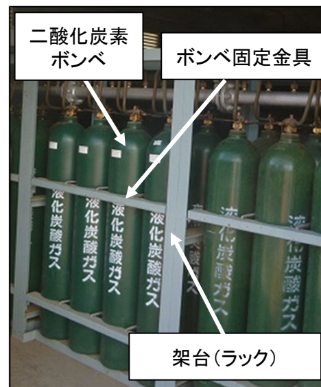
図18 敷地内におけるボンベの設置状況
