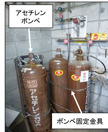
図18 敷地内におけるボンベの設置状況
