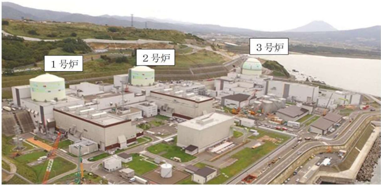
図 1.2-2 泊発電所の全景
