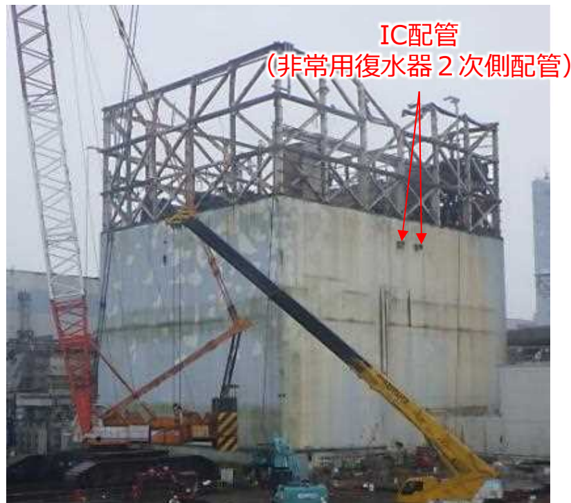
1号機原子炉建屋全景 (2021年6月19日時点)
