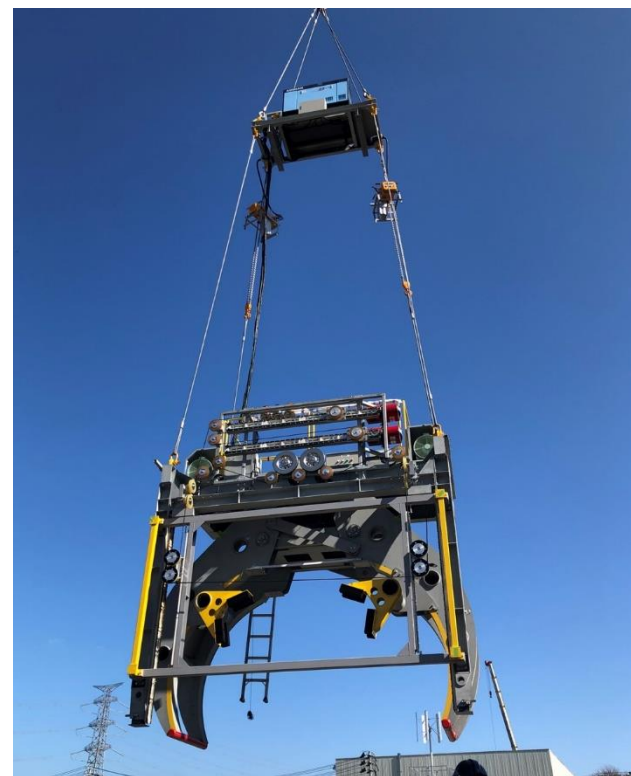
切断装置 吊り上げ状況写真（モックアップ時）
