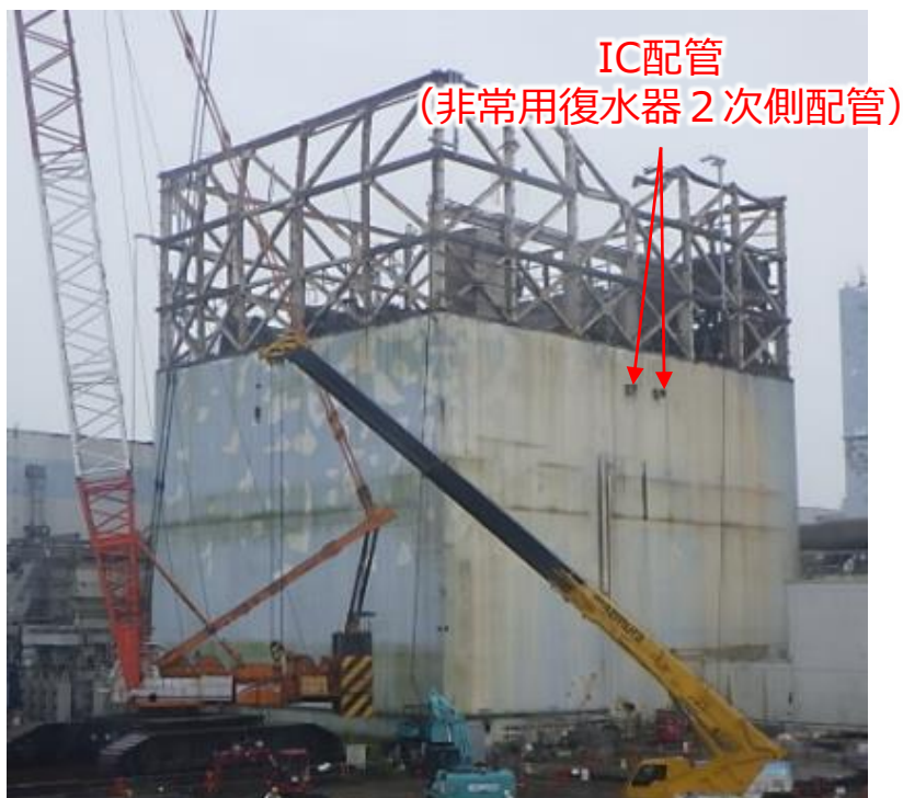
1号機原子炉建屋全景 (2021年6月19日時点)
