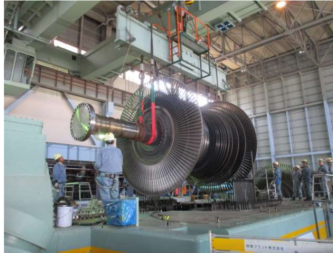
①ローター吊り上げ(2019年)
