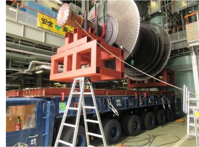
②大型輸送車へ吊り込み
