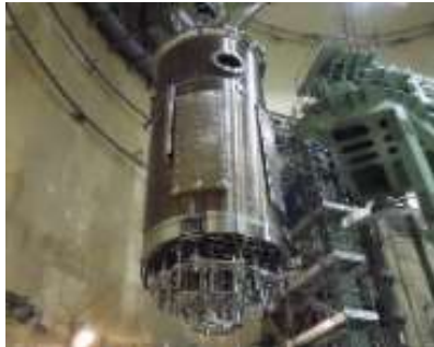
【新炉内構造物（外観）】
