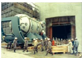
1969年6月 1号機 原子炉容器据付
