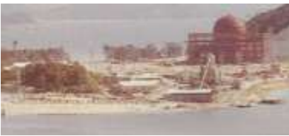
1967年5月 1号機 建設工事着工
