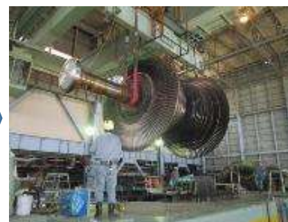
2号機低圧タービン吊り上げ
