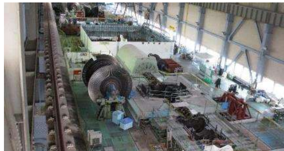
2号機低圧タービン吊り上げ
