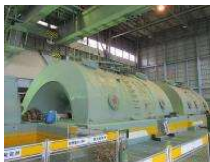
2号機低圧・高圧タービンの外観
