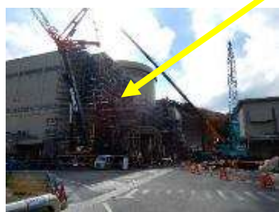
西側減築工事中
