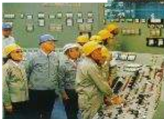
1970年 8月 1号機 万博会場へ初送電 1970年11月 1号機 営業運転開始
